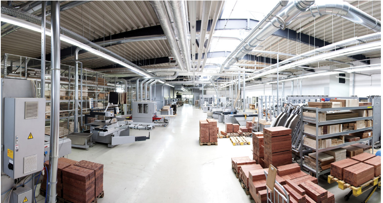
Abb. 11 Großzügige Dachfenster sorgen für eine bessere Tageslichtversorgung in der Produktionshalle. (Bild: Warwick GmbH & Co Music Equipment KG)
