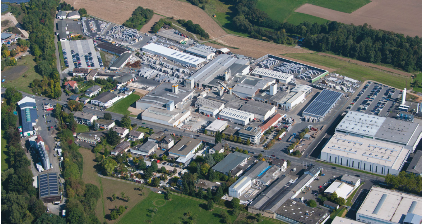
Abb. 10 Das Werk Heuchelheim nutzt für die Wärmeversorgung u.a. Geothermieanlagen, die diesen Standort seit 2014 auch mit Kälte versorgen. (Bild: Rinn Beton- und Naturstein GmbH & Co. KG)
