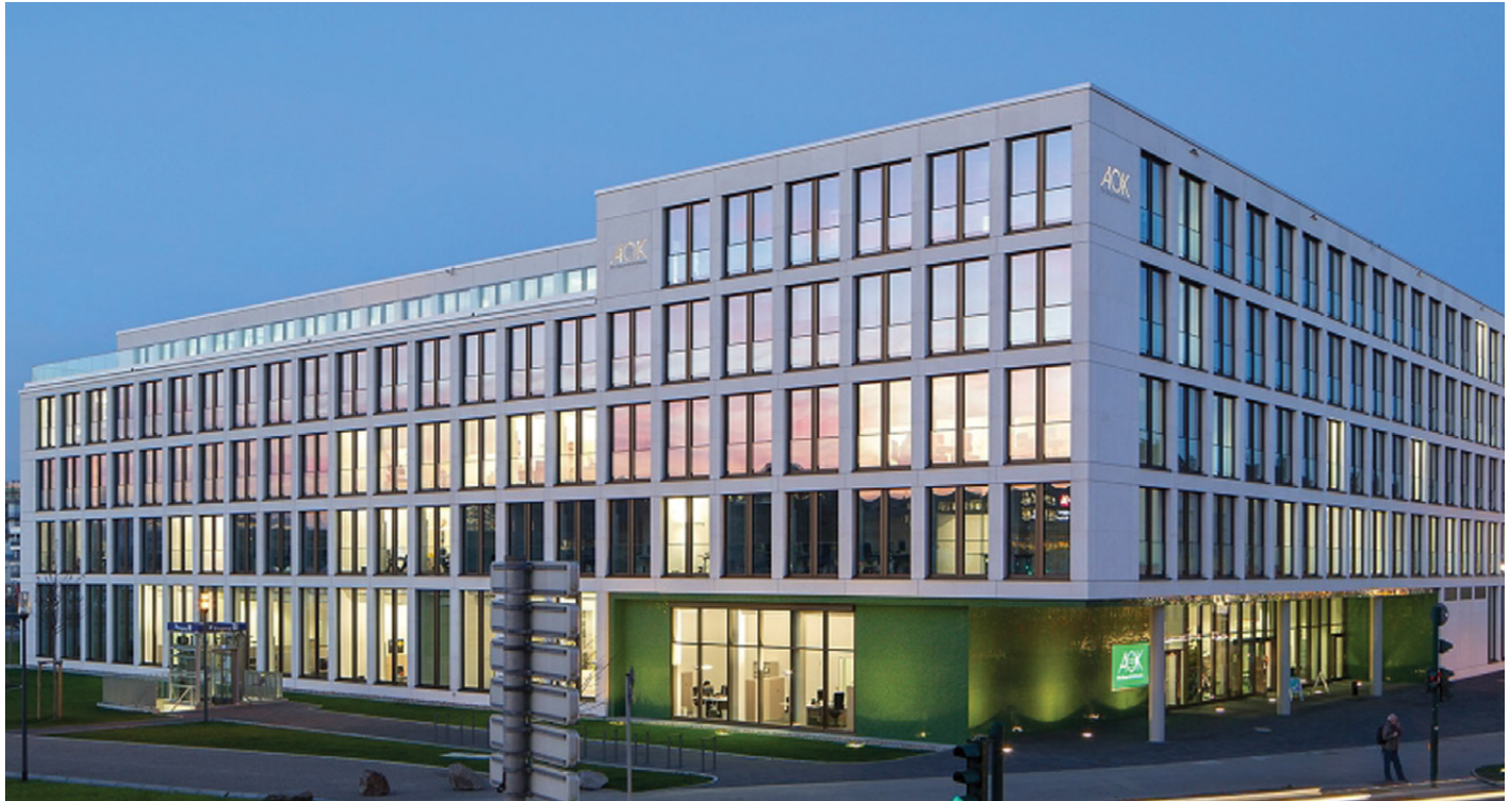
Abb. 1 Der Neubau der Regionaldirektion der AOK Rheinland/Hamburg wurde für seine Nachhaltigkeit von der DGNB ausgezeichnet. Entwurf: JSWD Architekten (Bild: Dirk Matull)
