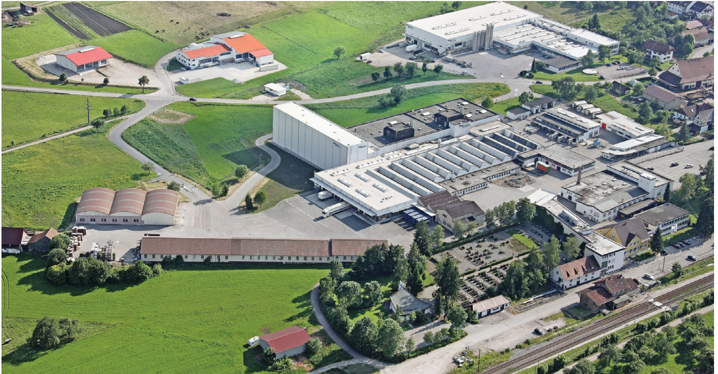
Abb. 12 Luftbild der Emil Frei GmbH & Co. KG: ein unterirdischer Regenwassertank liefert Kühlwasser für die Pulverlackherstellung, das dank einer Wärmepumpe effizient zur Gebäudeheizung weitergenutzt werden kann. (Bild: Emil Frei GmbH & Co. KG)
