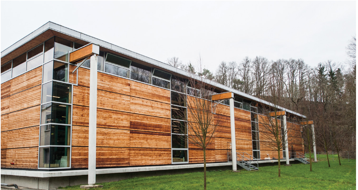
Abb. 8 Außenliegende Stützen sorgen für einen stützenfreien und flexiblen Innenraum der Produktionshalle der Sanha GmbH & Co. KG. Planung: Juhr Architekturbüro für Industriebau- und Gesamtplanung (Bild: SANHA GmbH)
