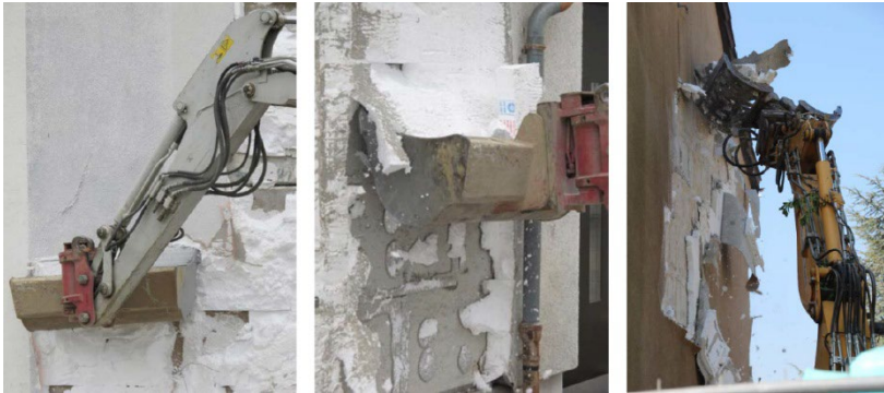
Abbildung 6: Selektives Abschälen der einzelnen Lagen eines WDVS. Oberputz (links), Dämmstoff (Mitte) und teilselektives Abschälen in der Praxis (rechts) 140
