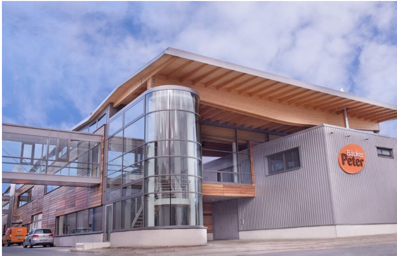
Abbildung 5: Die vollständig demontierbare und recycelbare Backstube Peter in Essen 105
