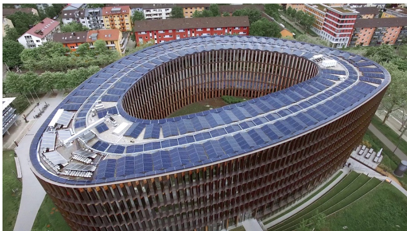
Abbildung 7: Photovoltaik-Module auf dem Dach und in der Fassade erzeugen Strom, PVT-Kollektoren (links im Bild) zusätzlich Wärme zum Betrieb der Kantine 253
