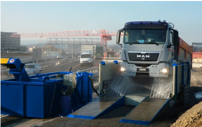
Abbildung 8: Reifenwaschanlage mit Wasser-Recycling © FRUTIGER Company AG/ MobyDick
