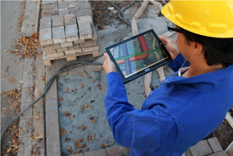
Abbildung 11: Augmented Reality zeigt versteckte baurelevante Elemente auf einer Baustelle © DFKI
